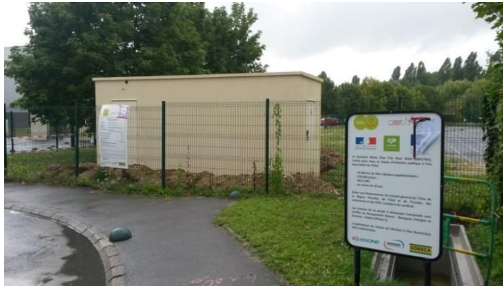
Nœud de raccordement optique
